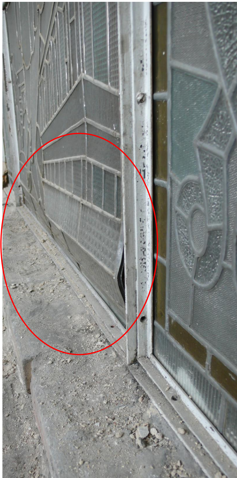
detail vytržení plátu z falcu - lámání plátu
