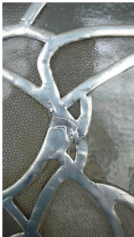
příklady řemeslně nezvládnuté práce s olověným profilem a jeho cínování
