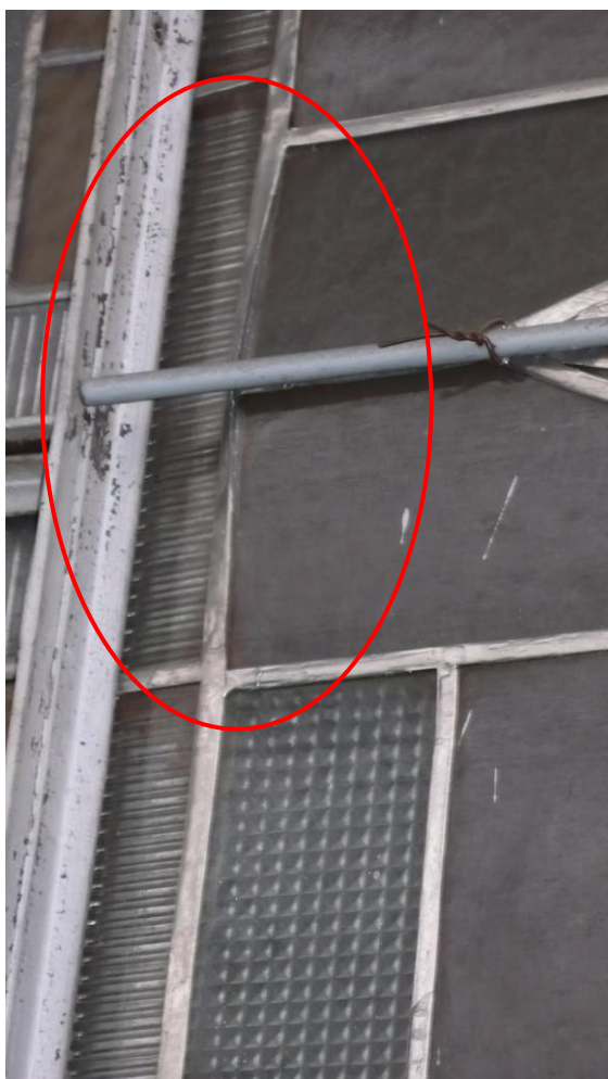
detail nefunkčních zavětrovacích výztuh, které naopak působí na plát destruktivně
