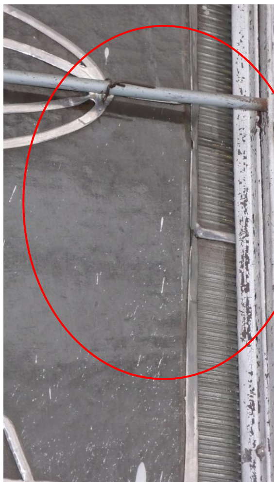
detail nefunkčních zavětrovacích výztuh, které naopak působí na plát destruktivně
